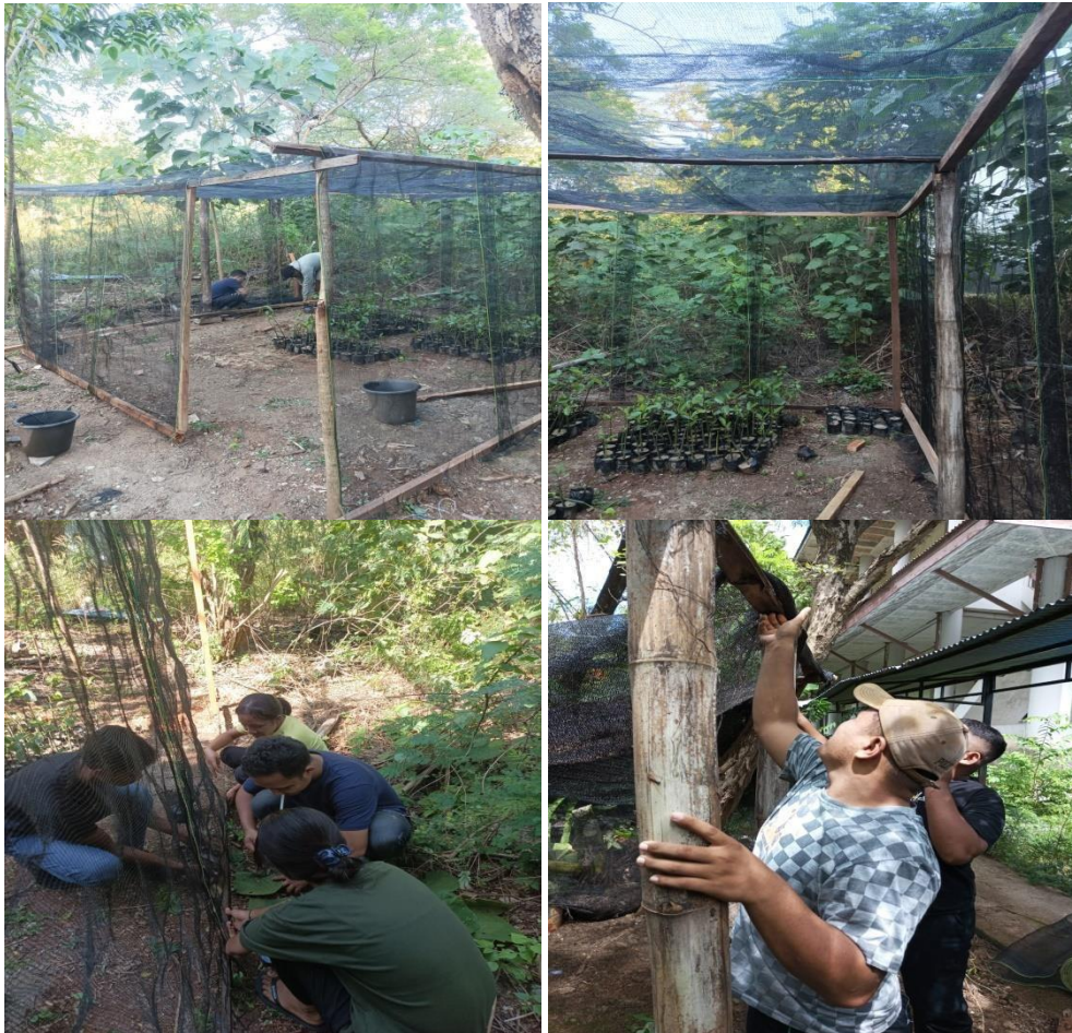
Gambar 2. Dokumentasi pemasangan pagar
